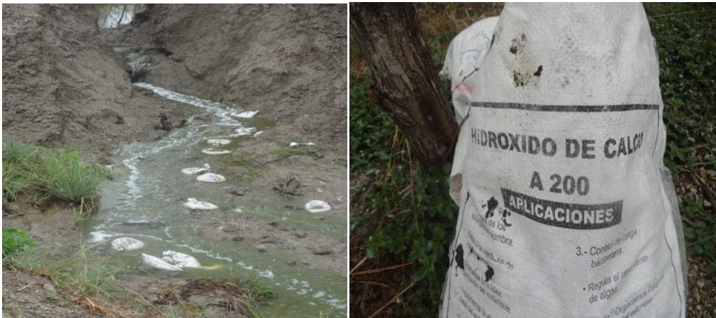
FOTO 5: Conducción de agua residual, tratada con hidróxido de calcio, hacia el estuario del río Cojimíes
