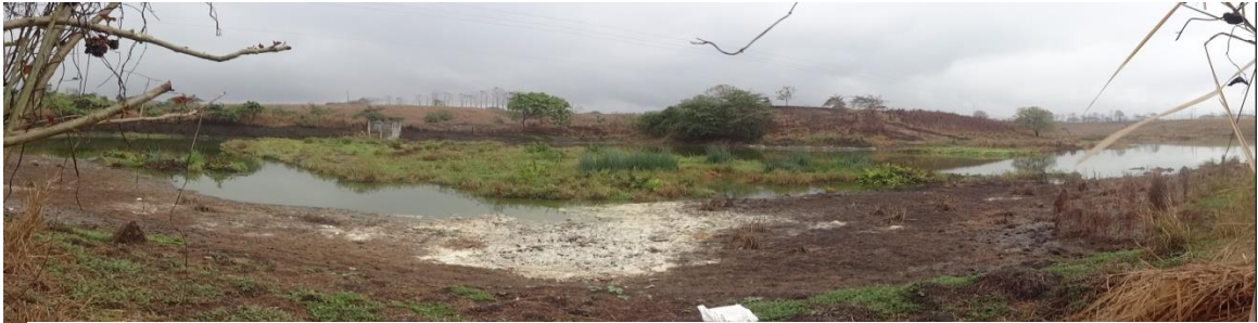
FOTO 3: Laguna de almacenamiento de aguas servidas, vía Cojimíes, en proceso de descontaminación
