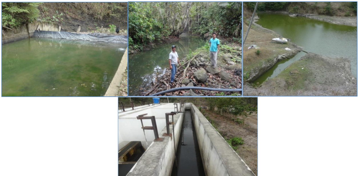
FOTO 2: Rio Tachina arriba. Albarrada y planta de tratamiento.
